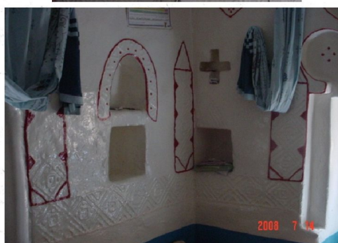
شكل 15: صورة توضح تشكيلات العقود فوق الأبواب والنوافذ، والفتحات المستخدمة لحفظ بعض أدوات المنزل
