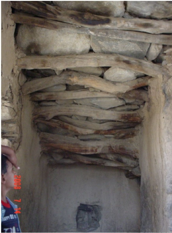
شكل 10: صورة توضح مكونات سقف الدرج
