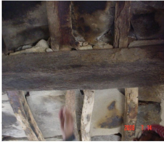
شكل 9: صورة توضح مكونات السقوف في المباني التقليدية
