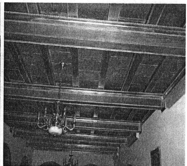
شكل 20: منظر داخلي لسقف استخدم فيه الجسور الحديدية بدلا من الأخشاب
