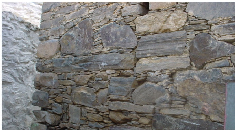
شكل 5: صورة توضح بناء الجدار وطريقة وضع المياضير تحت أو في جوانب الحجر للحصول على التوازن والترابط المطلوب
